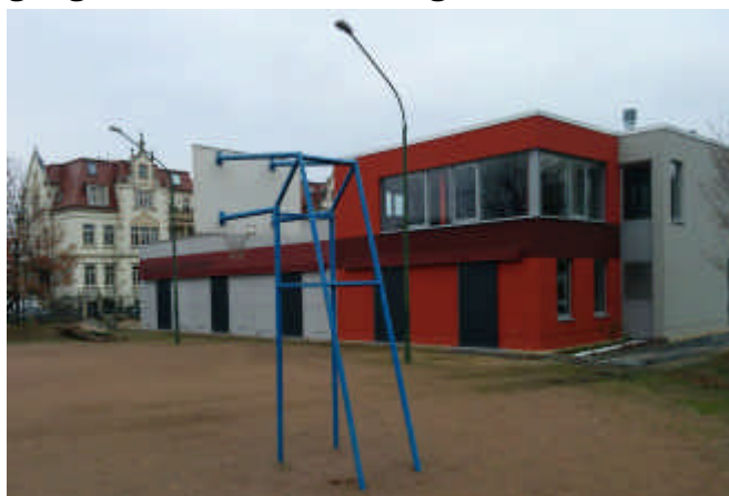
Neubau des Dresdner Rudervereins Foto: Franziska Lange
