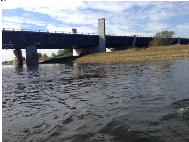
Die Trogbrücke von unten
